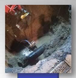
Gussrohr DN 500, Arbeitsdruck 21 Bar, tiefste Stelle
