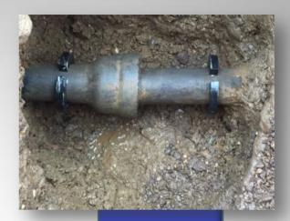
Gussrohr DN 80, Arbeitsdruck 14 Bar
