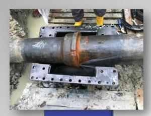
Gussrohr DN 450, Arbeitsdruck 12 Bar
