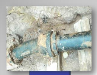
Gussrohr DN 100, Arbeitsdruck 10 Bar
