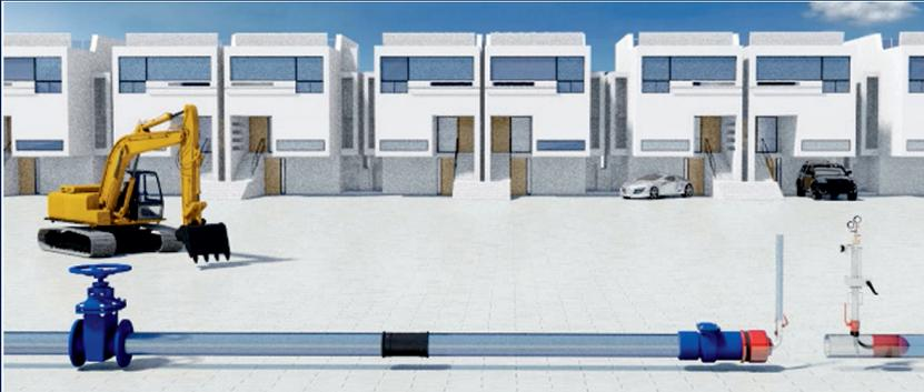
Installieren Sie das neue Rohrstück und montieren Sie die T-Stop M am Ende des neu installierten Rohrabschnitts.
