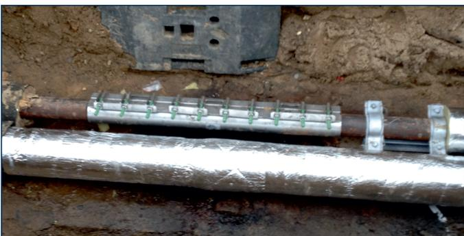
Edelstahl-Dichtschelle in DN 200 mit einer Länge von 2 Metern, ausgelegt für Pn16. Ausgestattet mit einer FPM Dichtung: Für Temperaturen bis 230°C geeignet.
