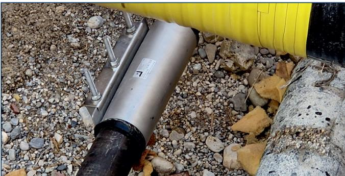
Dampfleitung mit 160 Grad: Eingesetzt wurde eine Thelen Edelstahl-Reparaturschelle in DN100 mit 1 Meter Länge, ausgelegt für PN 25.
