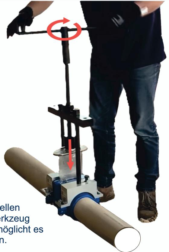
Die T-Stop PE, bestehend aus zwei Gusshalbschalen, einer speziellen Dichtung, einem Absperrkeil, der auch gleichzeitig das Schneidwerkzeug ist, zwei Haltebrücken und einem spindelgeführten Werkzeug, ermöglicht es Ihnen unter Druck stehende PE-Trinkwasserleitungen abzusperren.
