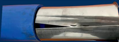
Die Stützhülse zusammendrücken und in das Rohr schieben
