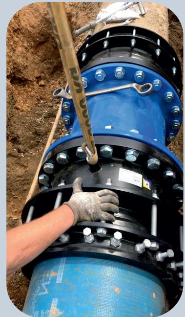
Zwei zugfeste Flanschadapter und ein FF-Stück DN 400, PN 16, aus Lagervorrat, per Kurier sofort geliefert
