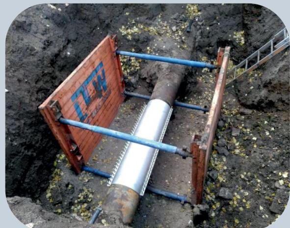
Dichtschelle aus Edelstahl DN 400, L = 1600 mm, Lieferung innerhalb von 48 Stunden auf die Baustelle
