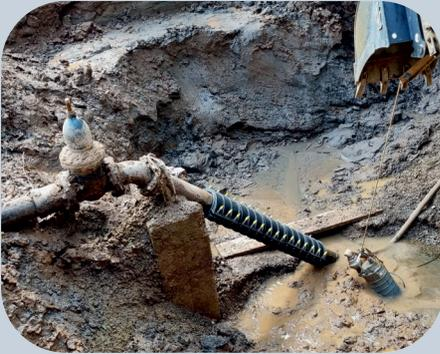
Lochfraß auf einer DN 150er Gussleitung. Repariert mit der patentierten verlängerbaren Dichtschelle. Eine beschädigte Fläche von ca. 1,50 m konnte Dank der Verlängerbarkeit schnell und einfach abgedichtet werden. Die Dichtschellen konnten sofort aus Lagervorrat geliefert werden.
