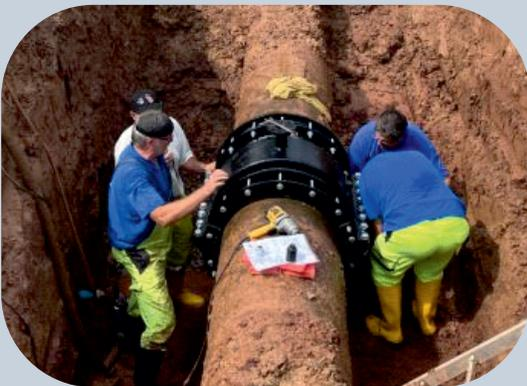
Bauchschelle DN 600 zur Reparatur einer defekten Muffenverbindung. Die Bauchschelle wurde nachmittags bestellt und nachts bereits ausgeliefert, so dass die Leitung schnellstmöglich repariert werden konnte.
